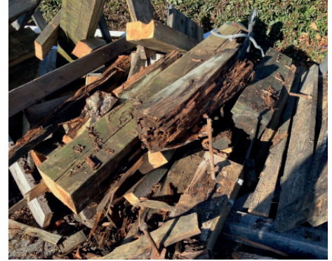
Die vermorschten Brückenteile
