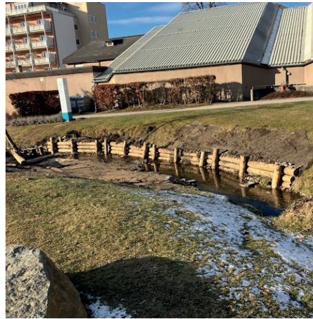
Längsverbauung an der Böschung des Mühlbachs
