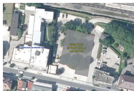
Die Eisstocksporthalle schließt die Baulücke an der Hauptstraße
