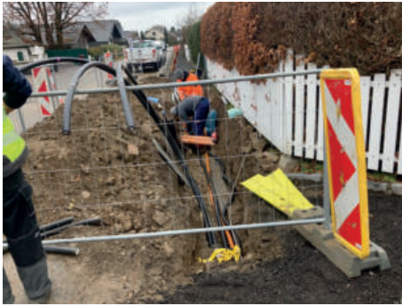
Eine Reihe von Versorgungsträgern waren mitzuverlegen
