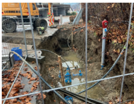
Zusammenschluss der Wasserleitung Winklernerstraße/Karawankenblickstraße; starker Grundwasserandrang erschwerte die Arbeit
