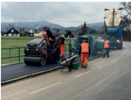
Asphaltierung des Gehsteigs
