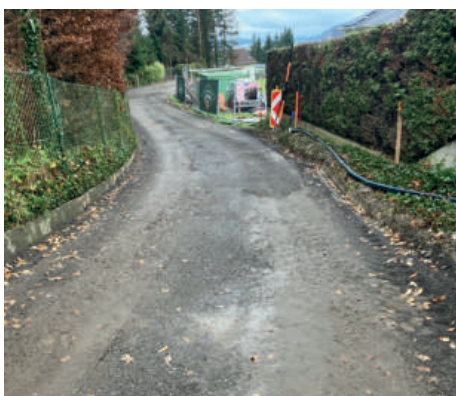
Die Winklernerstraße ist wieder befahrbar
