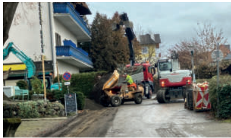
Umfangreiche Arbeiten im Bereich der Marienstraße
