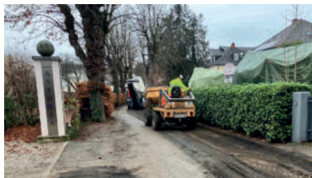
Die Künetten werden verdichtet und aufgefüllt
