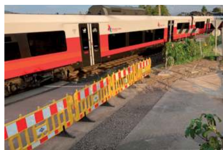
Schon sind die Fundamente für die Schrankenanlage errichtet
