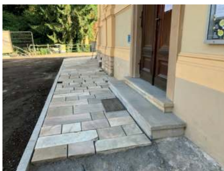
Der alte Steinplattenbelag aus edlem Pörschacher Marmor wird wieder verlegt
