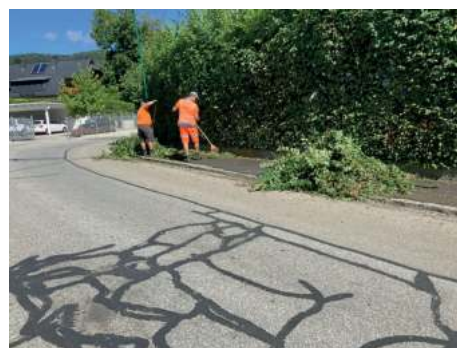
Heckenschneiden entlang der Gehsteige in der Moosburgerstraße
