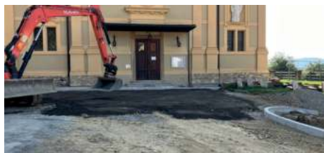
Das Planum am Vorplatz wird für die Asphaltierung eingeebnet
