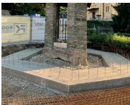
Das Planum am Vorplatz wird für die Asphaltierung eingeebnet
