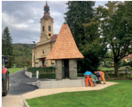
Beim sanierten Krieger- und Abwehrkämpferdenkmal stellen Bedienstete des Bauhofs die Bänke wieder auf
