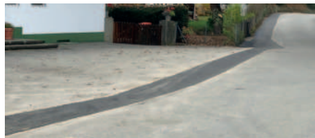
Lange Längskünette in der Karawankenblickstraße – hoffentlich bleibt die Instandsetzungsfläche dauerhaft eben!
