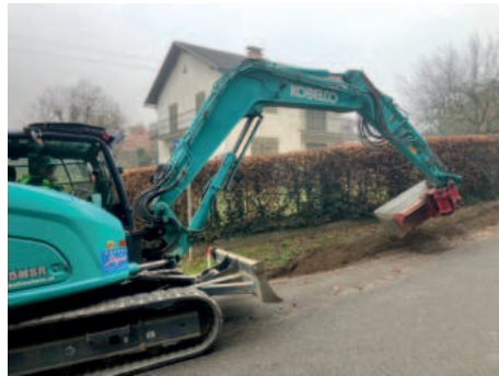
Auftragung von Humus an Straßenböschungen
