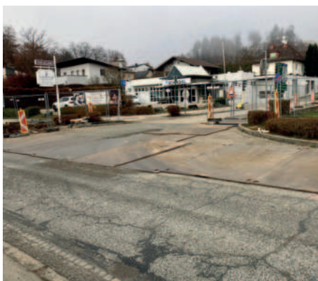
Zufahrt in die Gaisrückenstraße ist mit Stahlplatten abgedeckt
