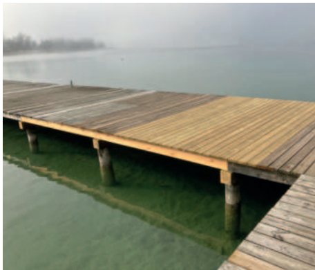
Reparierter Steg mit neuem Belag
