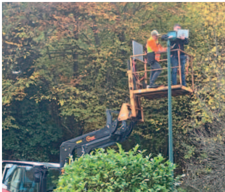
Umprogrammieren der Lichtstellen für die Nachtabsenkung
