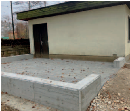
Unterbau für den Zubau beim „Besenschwingerheim“
