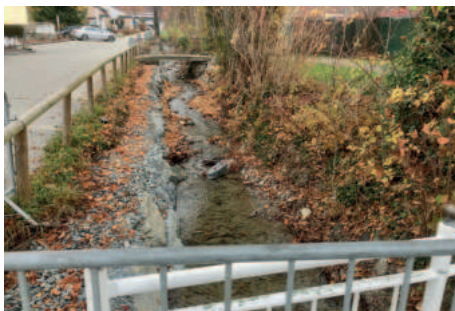
Massive Verbauung des linken Mühlbachufers
