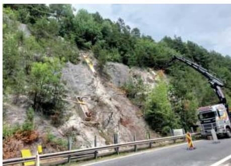
*Einbau von Felsankern - Stahlgitter sichern hier die Felsoberfläche*
