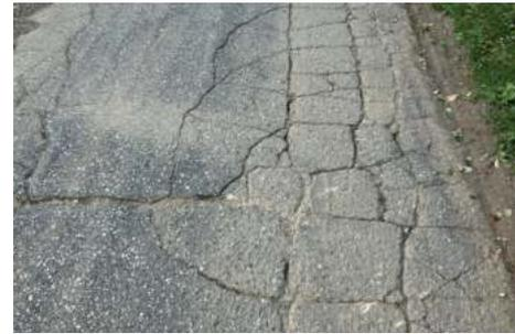
*Der desolate Bogenweg, der im Querprofil mittig Überhöhungen bis zu 10 cm aufweist*
