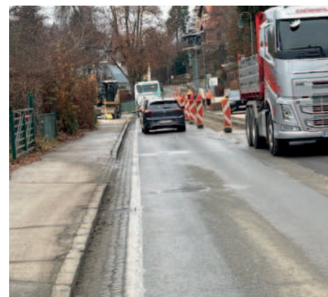
Asphaltierung der Grabungskünette in der Hauptstraße beim Edelweißbad
