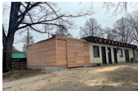
Gefällige Gestaltung des Zubaus in Holzleichtbauweise
