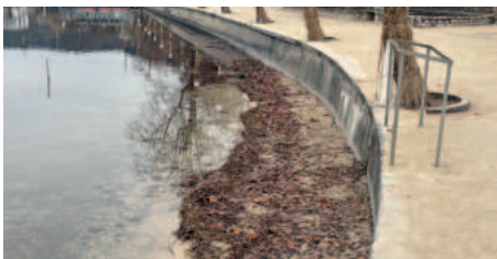
Verlandungen vor der Kaimauer der Johannes-Brahms-Promenade müssen ständig entfernt werden
