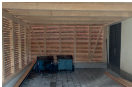
Licht und luftig wirkt der Zubau durch die Verlattung der Außenwände
