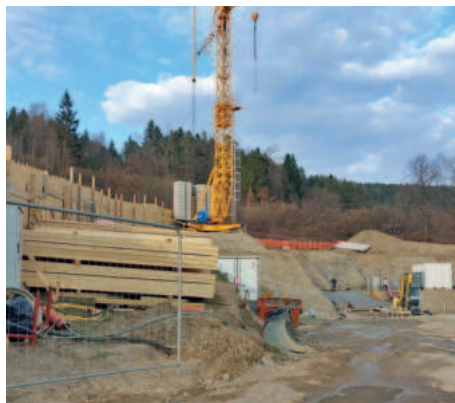
Blick vom Süden auf die Baustelle
