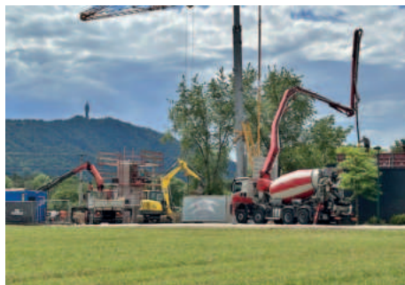
Umfassende Bauarbeiten beim PriorIT-Bürogebäude
