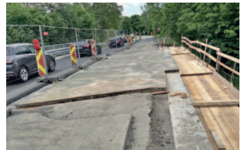
Abgetragene südliche Brückenfahrbahn
