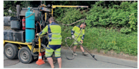
Bei Straßenkünetten wurden Asphaltfugen gefräst und diese mit Bitumen abgedichtet
