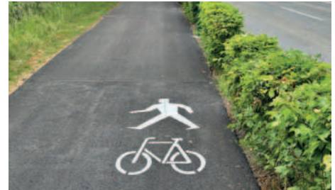
Neuer Belag und Markierung am Geh- und Radweg in Sallach/Pritschitz
