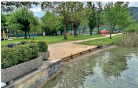
Eine kleine, fachmännische Uferbefestigung am Einstieg ins Wasser
