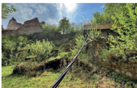
Die Stromzuleitung der Ruine Leonstein funktioniert wieder
