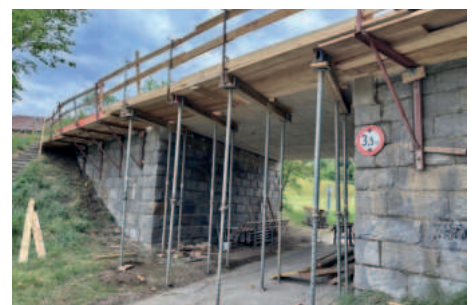
Brückensanierung aus Sicht von unten
