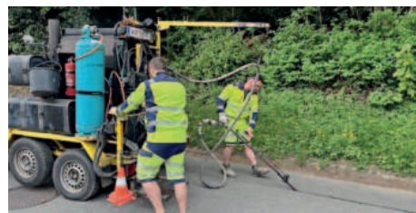
Bei Straßenkünetten wurden Asphaltfugen gefräst und diese mit Bitumen abgedichtet
