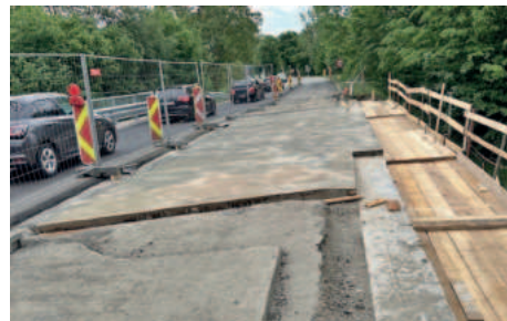
Abgetragene südliche Brückenfahrbahn
