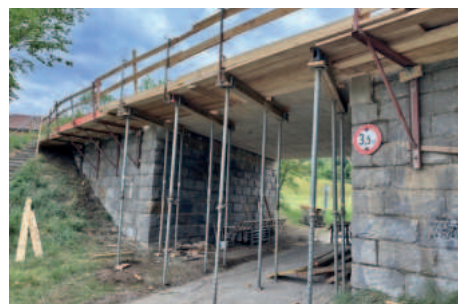
Brückensanierung aus Sicht von unten
