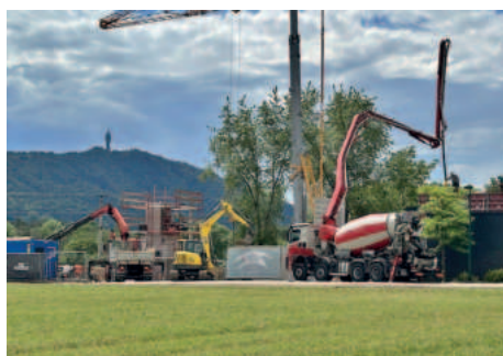
Umfassende Bauarbeiten beim PriorIT-Bürogebäude
