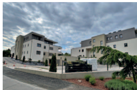
Blick vom Westen auf die beiden Baukörper von „The Lakes“
