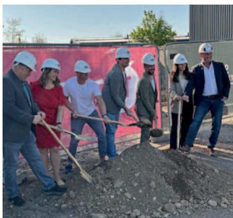
Spatenstich mit Bgm. Häusl-Benz, den Vertretern der Fa. priorIT, den Planern von Lend Architektur und der Baufirma SSB Bau GmbH
