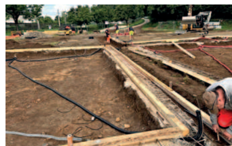
Massive Fundamente für die Wände
