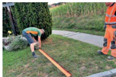
Vorarbeiten für den Plattenbelag beim Kochwirtkreuz
