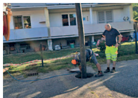
Wartung einer Sickergrube am Bogenweg
