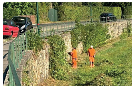
Entfernen des Bewuchses an der Natursteinmauer in der Seeuferstraße
