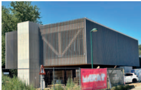
Hinter der senkrechten Holzlattung ist das massive Holztragwerk erkennbar
