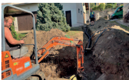
Beim Wohnhaus am Kirchweg wurden ein neuer Elektromast und eine Versorgungsleitung verlegt
