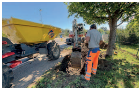
Grabung für die Wasserleitung neben der Hauptstraße...
