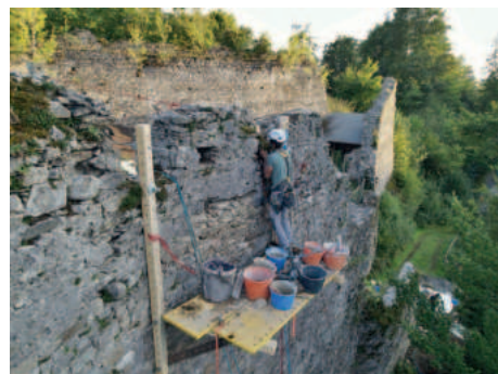
Einsatz hoch über dem Gelände bei der Mauersanierung
