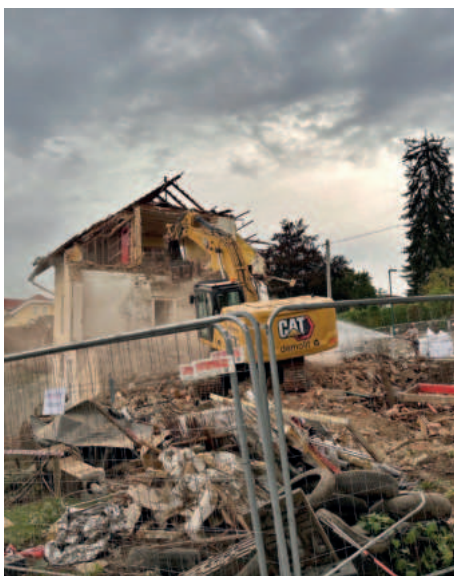
Der Abbruch erfolgte zügig
