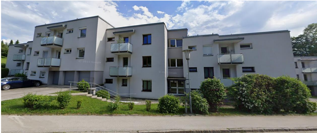
Abbildung 5: Geschößwohnbauten südlich angrenzend zum Planungsraum, Quelle: Google Street View
